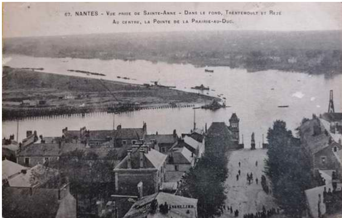
Vue générale depuis le quartier Sainte-Anne, côté Nantes
